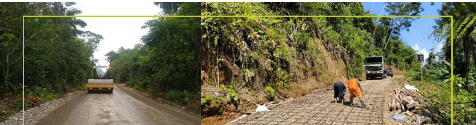
Fuente: Fotografías actualizadas de la Carretera Boca Manu (CUI N° 2356400)
